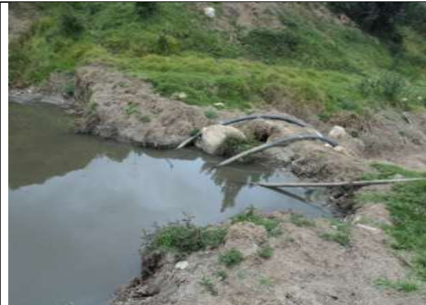
Foto No. 3. Punto de captación. Mangueras sumergidas.
